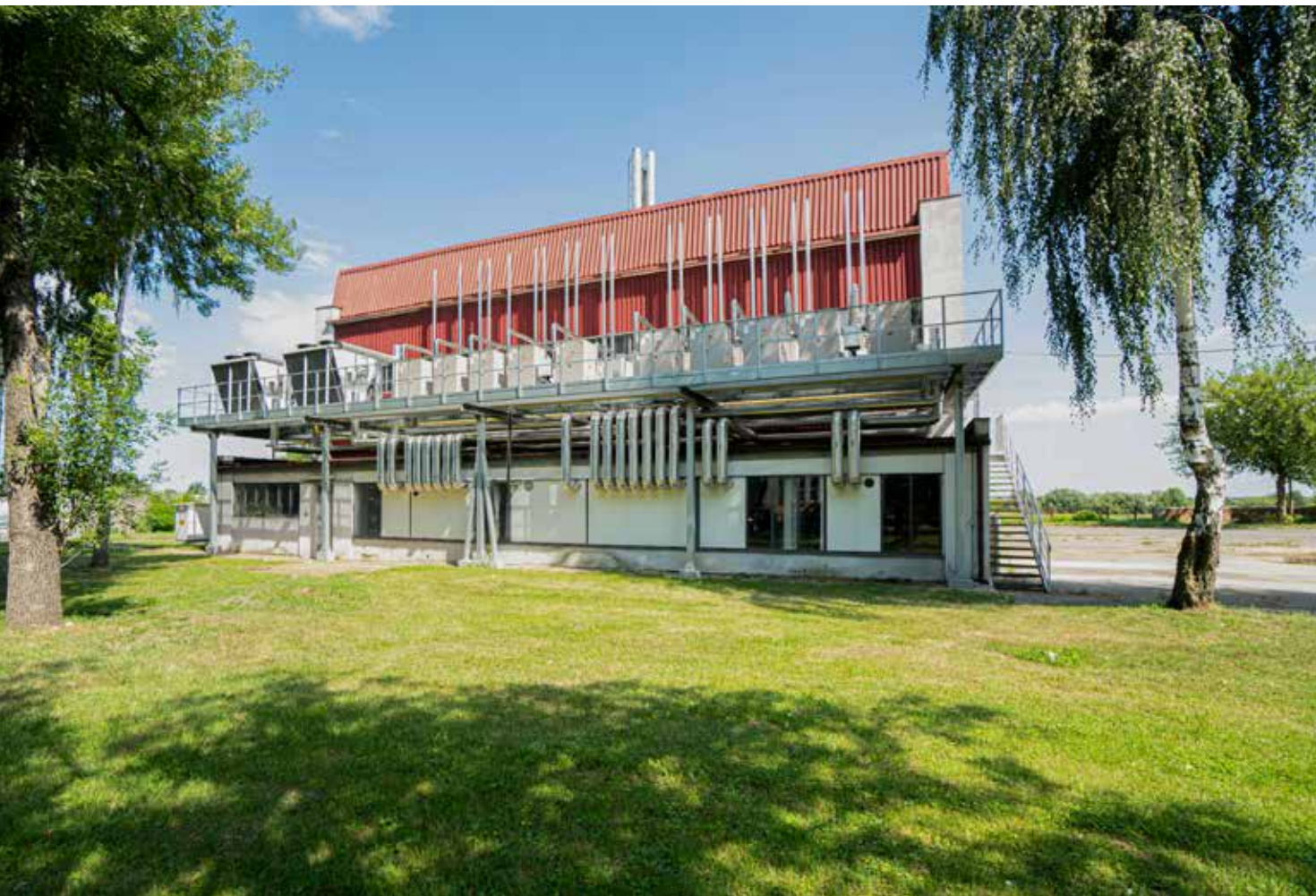
Szpital w Warcie 21 gruntowych absorpcyjnych pomp ciepła GAHP-GS HT o łącznej mocy ok. 820 kW
