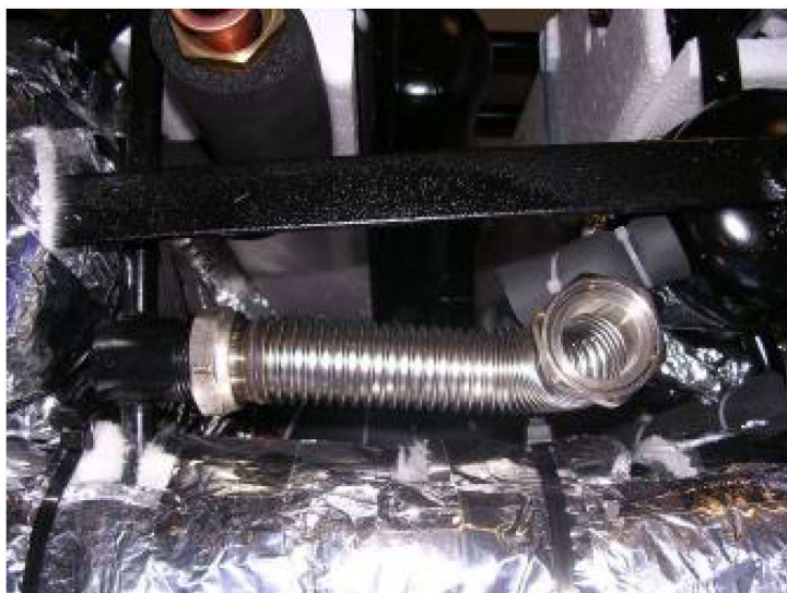
Element giętkiego przewodu odprowadzenia czynnika roboczego.
